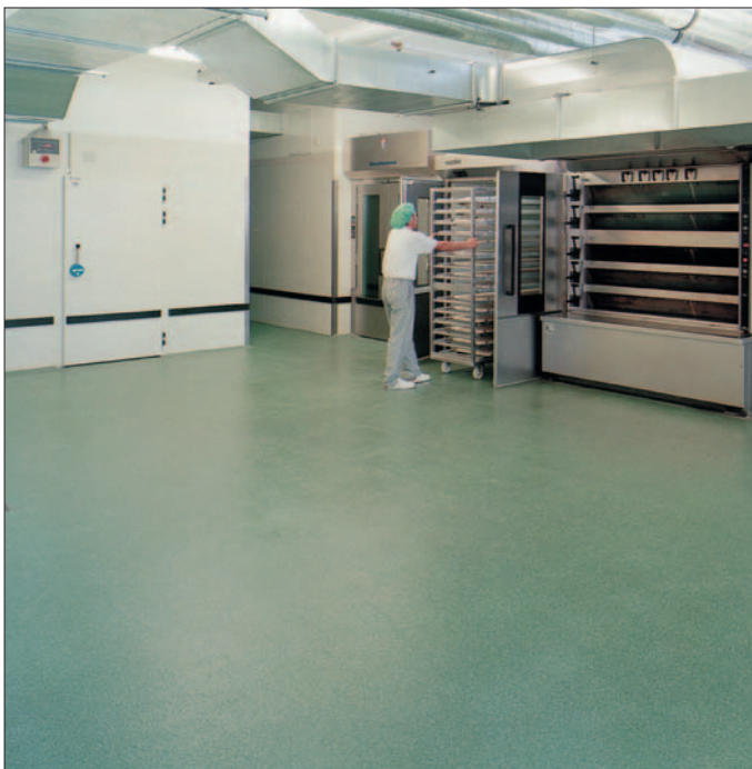
Метилметакриловое покрытие DURACON® толщиной 6 мм, 15 лет в эксплуатации, сыродельный завод (г. Мрехен, Болгария)
